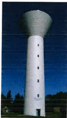
un château d'eau
